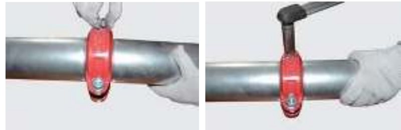
Рис.3. Грувлочное соединение жесткой муфтой.
